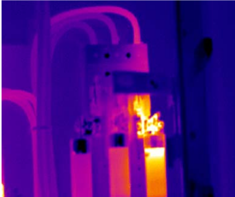
Fig.15 Inspección de conectores
